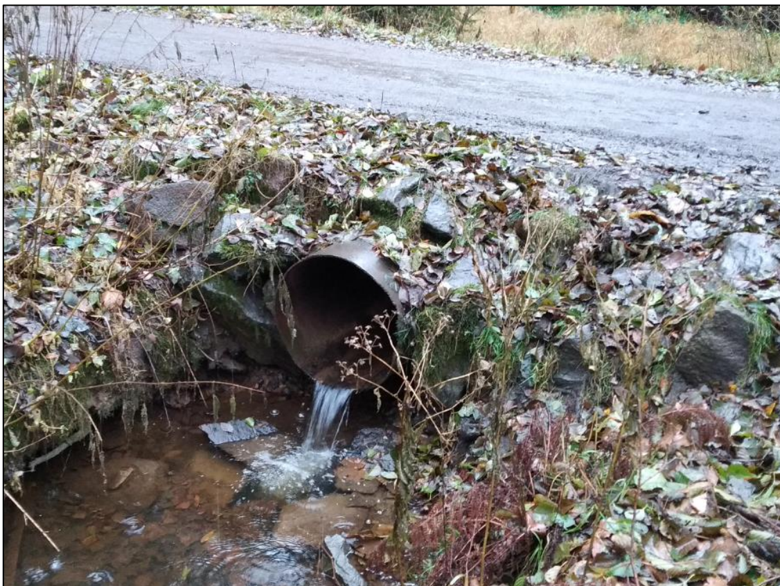
Obr. 38 Propustek ocel DN600 na soutoku Medlovky a bezejmenného levostranného přítoku
