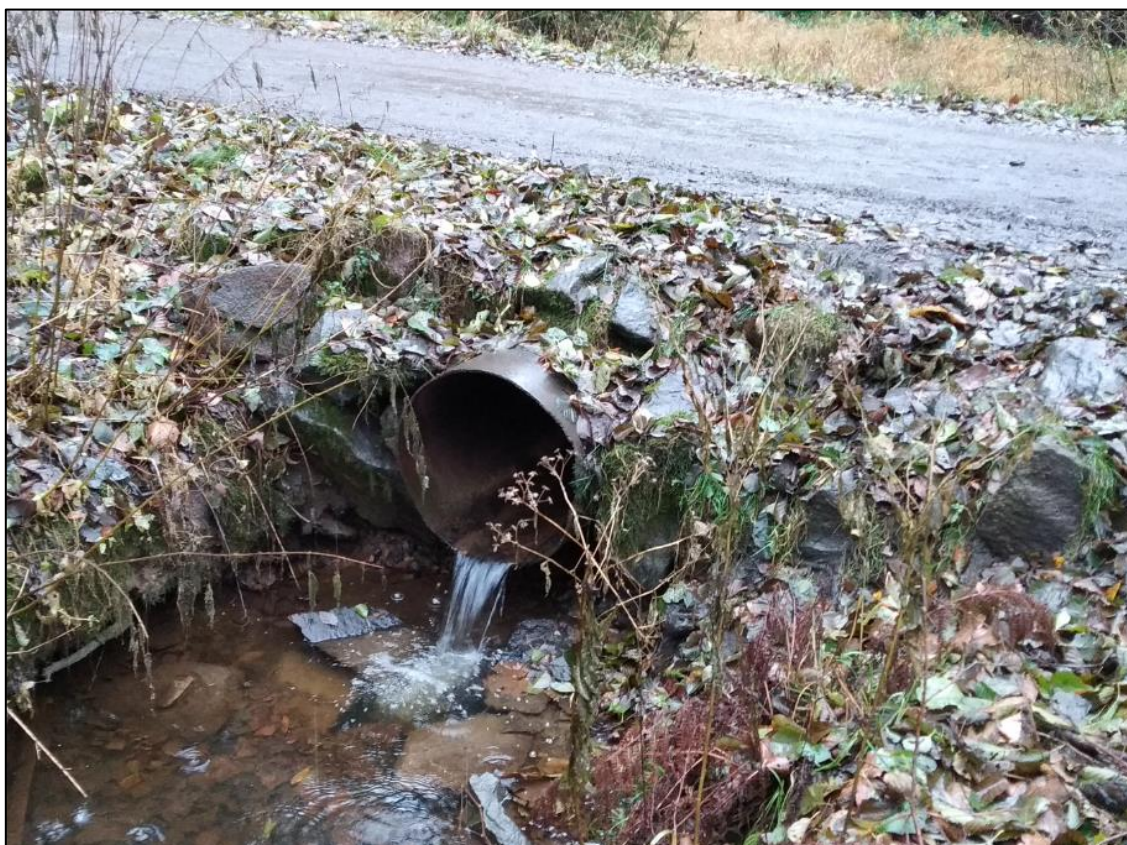
Obr. 5 Propustek ocel DN600 na soutoku Medlovky a bezejmenného levostranného přítoku
