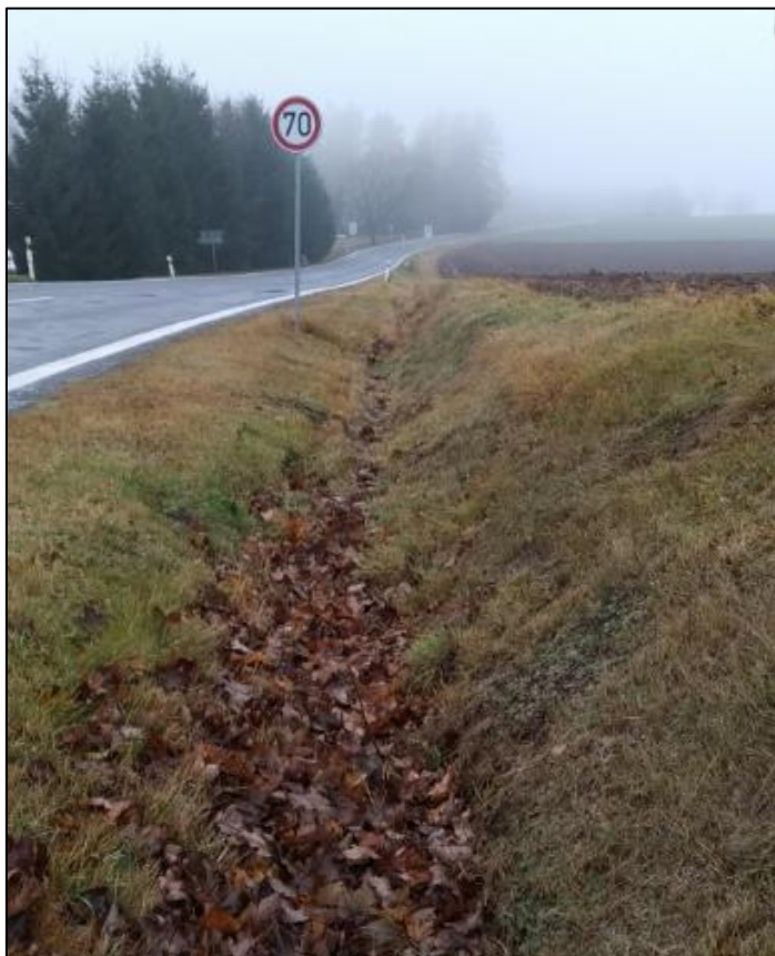
Obr. 13 Příkopy odvodňující cesty
