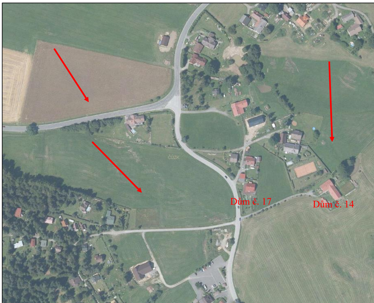
Obr. 25 Vyznačení průběhu povodně z roku 2015
