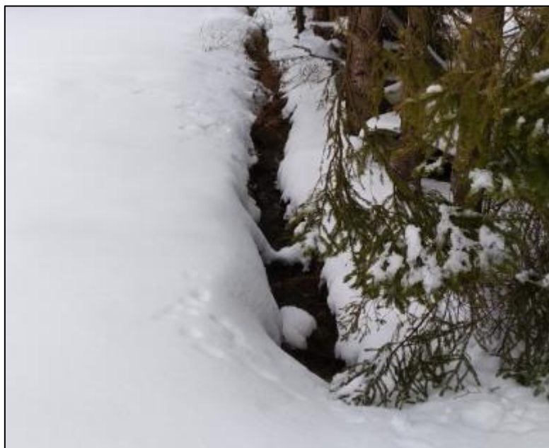
Obr. 18 Stávající systém odvodnění chatové oblasti – odtokové rýhy
