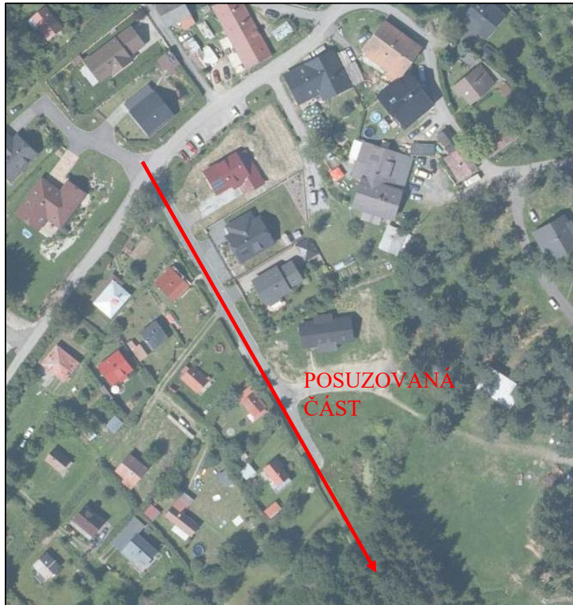
Obr. 19 Posuzovaná lokalita dešťové kanalizace u zástavby RD
